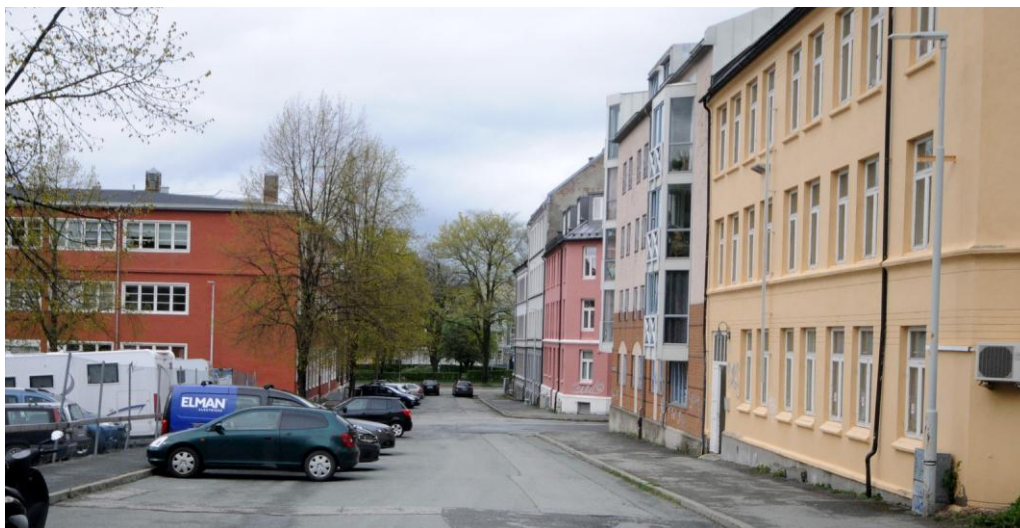
Aslak Bolts gate - 2019. Foto: Bjørn Lien.
